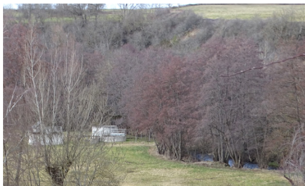
Station d'épuration du bourg dont le milieu récepteur est la Sioule
