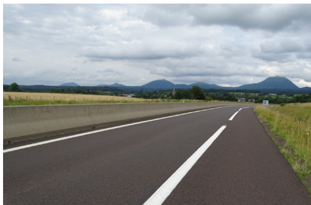
Traitement routier de la RD 2089.
