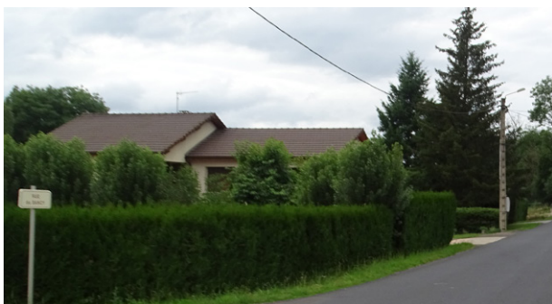
Pavillons construits dans les années 1970 au Pont d'Olby
