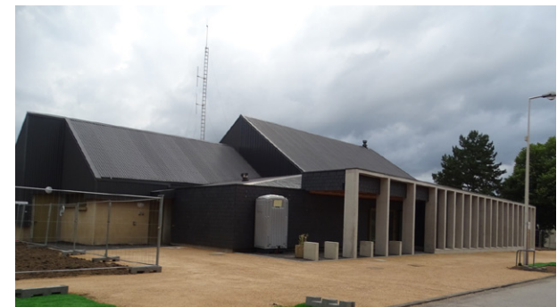
La salle de fête en cours d'achèvement des travaux
