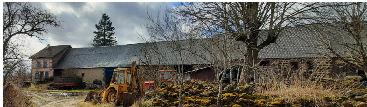
Ferme à bâtiments alignés à La Gardette : le logis se distingue clairement des grange-étables par sa hauteur et le dessin de la façade
