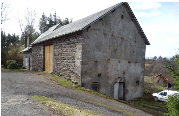
Exemple d'utilisation de la pente pour l'organisation du bâtiment : accès de plein pied depuis la rue haute à la grange et depuis la rue basse à l'étable
