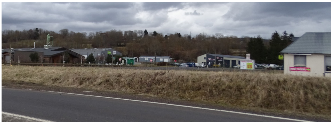
Les bâtiments artisanaux présents sur la commune d'Olby aux Quatre Routes de Nébouzat : leur intégration paysagère pourrait être améliorée par des plantations et un aménagement paysager des espaces extérieurs, mais tout comme pour les stabulations agricoles, on note que les matériaux sombres et le bois renvoient une image plus qualitative que les tôles ondulées claires.
