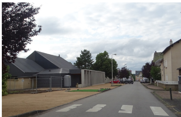
La salle des fêtes rénovée et la Grand Rue
