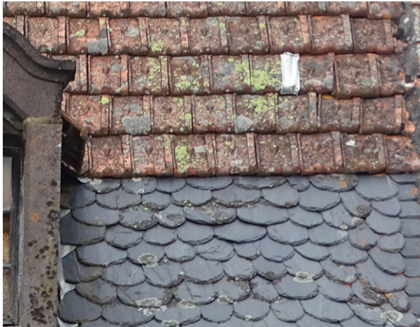
Toiture mixte en tuile et ardoise, encadrement de lucarne en pierre
