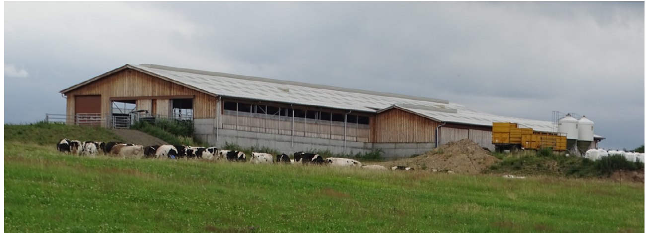
La qualité architecturale de ce bâtiment agricole est intéressante, toutefois sa localisation en haut de butte et l'absence de végétation la rend visible de très loin (photo du haut)
