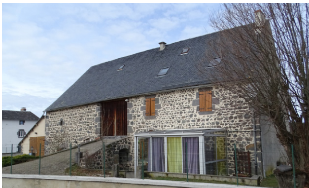
Exemple d'une ferme « maison-bloc » dans le bourg : sous un même toit sont regroupés la grange, l'étable et le logis (à droite sur la photo) ; au centre, on distingue la montade permettant l'accès à la grange
