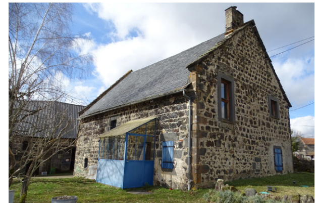
Ancienne véranda : la pente de sa toiture se rapproche de celle du bâtiment principal, la finesse de l'armature métallique participe à son intégration à la construction
