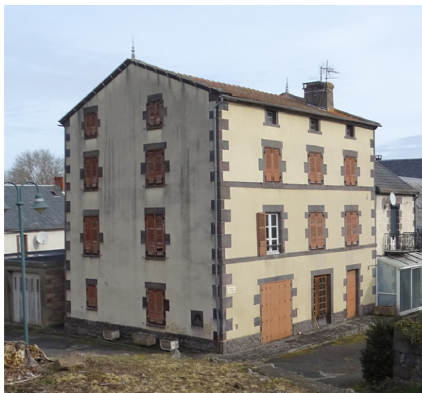
Maison sur 3 niveaux (R+2) dans le bourg historique : bâtiment le plus haut du bourg après l'église ; il a été bâti avant 1823, le rez-de-chaussée devait accueillir des commerces
