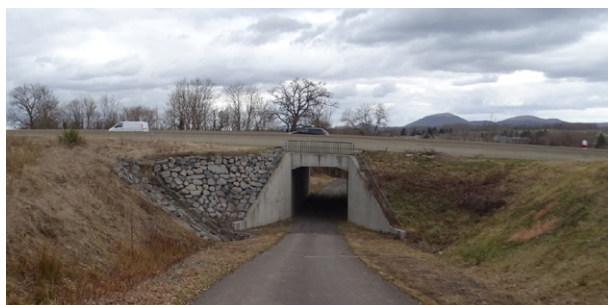
La RD 2089, principal facteur de fragmentation. Le boviduc est une mesure de réduction d'impact pour le passage de la grande faune.
