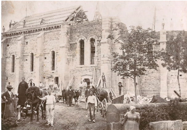
Carte postale ancienne montrant les travaux de reconstruction de l'église Saint Pierre (réalisés entre 1896 et 1898) - Source : base POP
