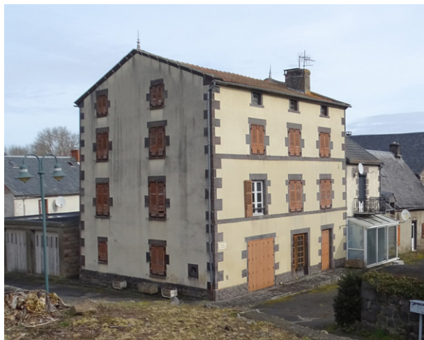
Immeuble dans le bourg avec des logements vacants. Il est cours de rénovation
