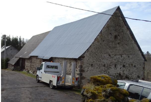
La forte pente de la toiture lui confère une part importante dans le dessin de la façade
