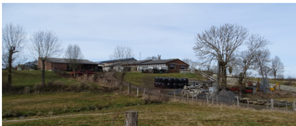
Vue arrière d'une fermes composées de plusieurs grands bâtiments située à l'est du bourg
