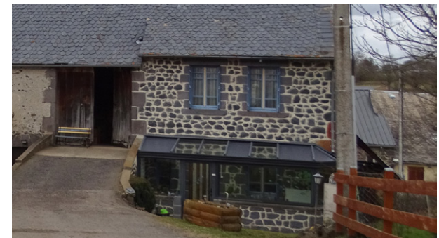
Véranda révélant une recherche d'intégration architecturale au Monteillet : une toiture plus pentue aurait toutefois pu l'améliorer
