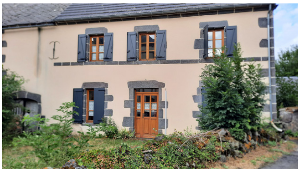
Rénovation dans le bourg : menuiseries en bois, enduit fin laissant les linteaux de lave apparents et teinte des volets en harmonie avec les pierres d'encadrement
