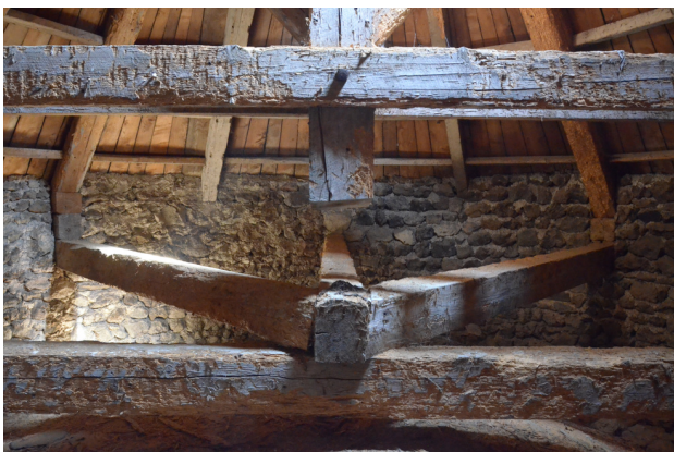
Charpente du chœur
